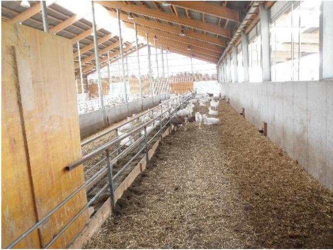
Abb. 2 Curtains und Wickellüftungen können positive Effekte in Bezug auf Lüftung, Schutz und Temperatur aufweisen. (Bild: HBLFA Raumberg-Gumpenstein)
